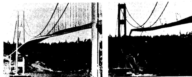
**Figura 21** El puente del estrecho de Tacoma en Puget Sound, Washington (EU). Terminado y abierto al tránsito en julio de 1940, de inmediato mostró oscilaciones de balanceo suaves debidas a la resonancia. Más tarde, el puente desarrolló violentas oscilaciones torsionantes que pueden apreciarse en la figura de la izquierda. Finalmente el claro principal se rompió, haciendo que la losa del puente se cayera al agua, como se muestra en la figura de la derecha.
